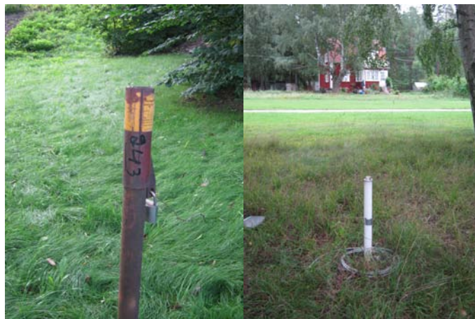
Figur 3-4. Grundvattenrör för provtagning kan se lite olika ut. Här är exempel från två platser i staden. Foto: Ulrik Fried.
