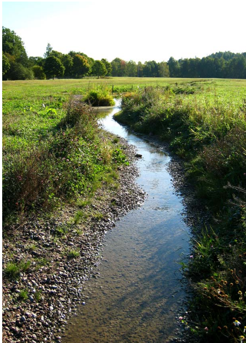
Vid Laduviken har en damm och ett öppet dagvattenstråk anlagts för att minska tillförseln av förorenande ämnen som kommer med dagvattnet. Foto: Magnus Sannebro.
