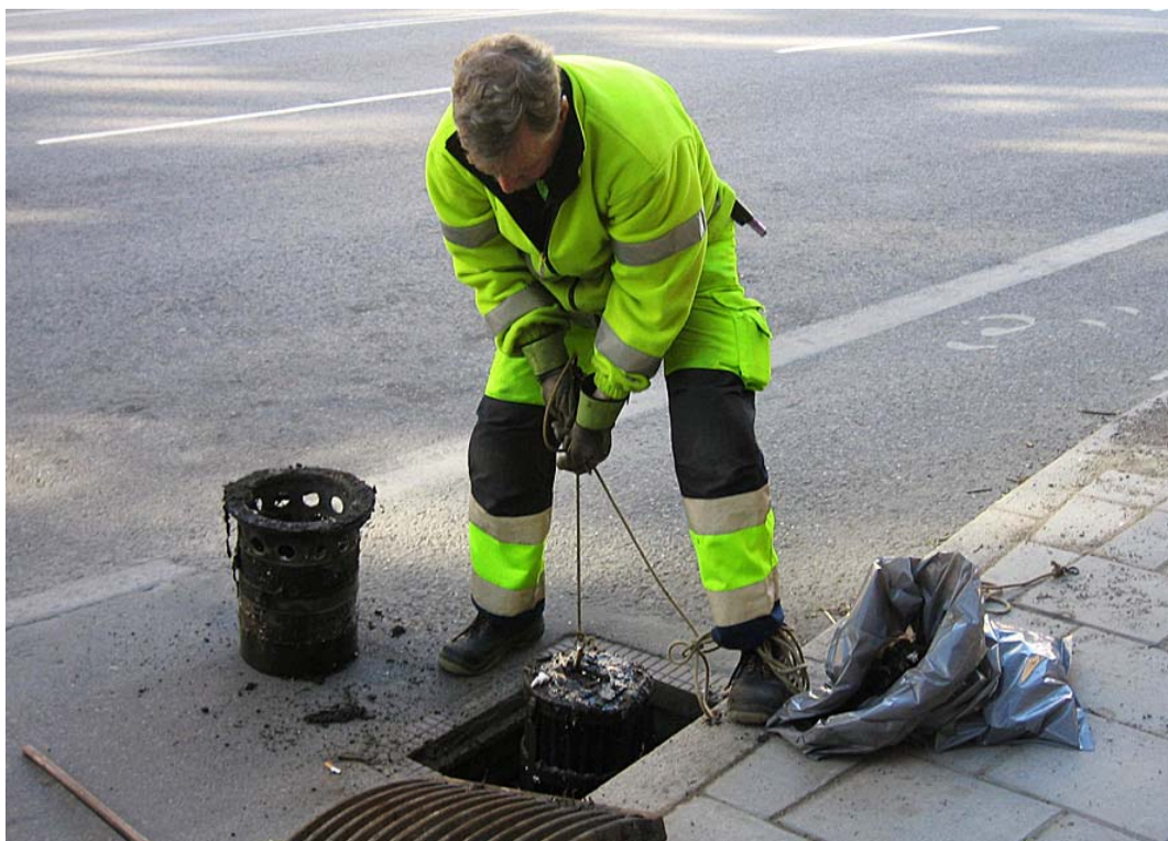
Stockholm Vatten har undersökt hur filterinsatser i dagvattenbrunnar fungerar för att rena dagvatten från föroreningar. Bilden visar en dagvattenbrunn på Sveavägen. Foto: Pia Dromberg.
