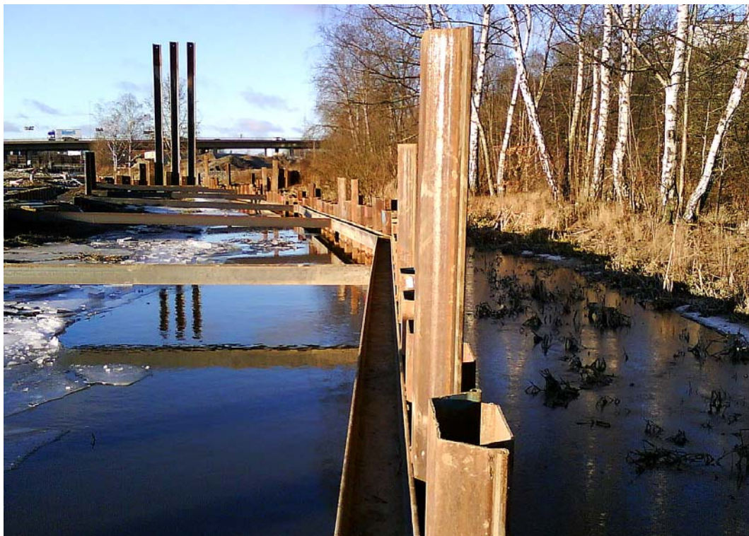
Vid Annedal har muddringsarbeten genomförts i Bällstaån. Syftet var att bredda och fördjupa ån, samt att göra årummet mer tillgängligt för boende i den nya stadsdel som byggs i Annedal. Foto: Örjan Magnusson.
