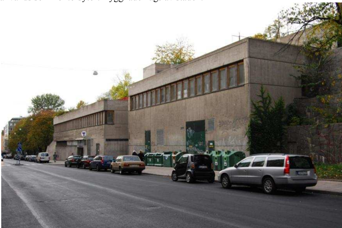
Tunnelbyggnaden på Hornsbruksgatan. Foto JTP
