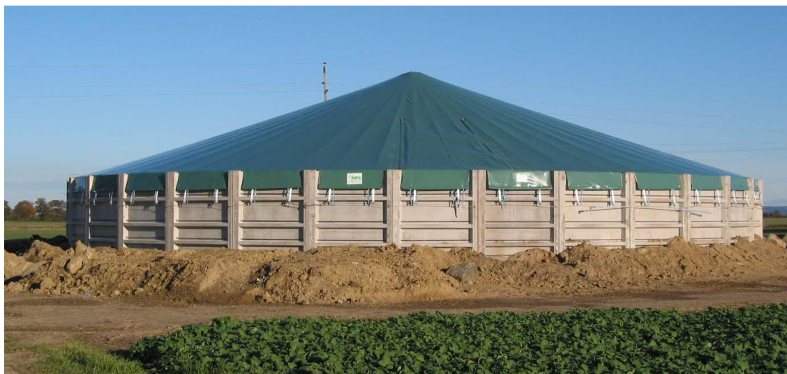
Figur 16. Betongbrunn med tak för lagring av biogödsel. (Källa Avfall Sverige U2010:11/MPG)
