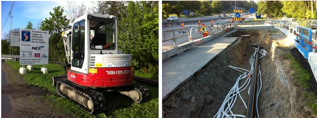
Figur 10. Fordonsgasledningsarbete vid Liljeholmen, maj, juni 2011.
