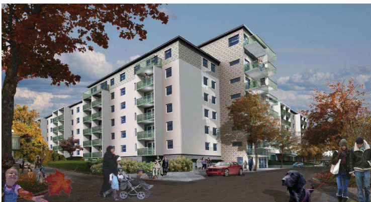
Kvarteret Trondheim efter renovering. (Källa: Svenska Bostäder)
