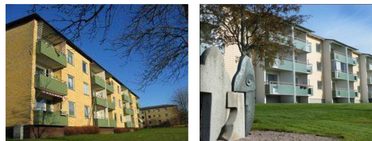
Husen i Brogården, före och efter upprustning
