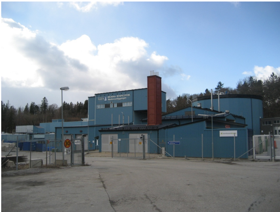
Figur 6. Bromma avloppsreningsverk, Åkeshovsanläggningen
