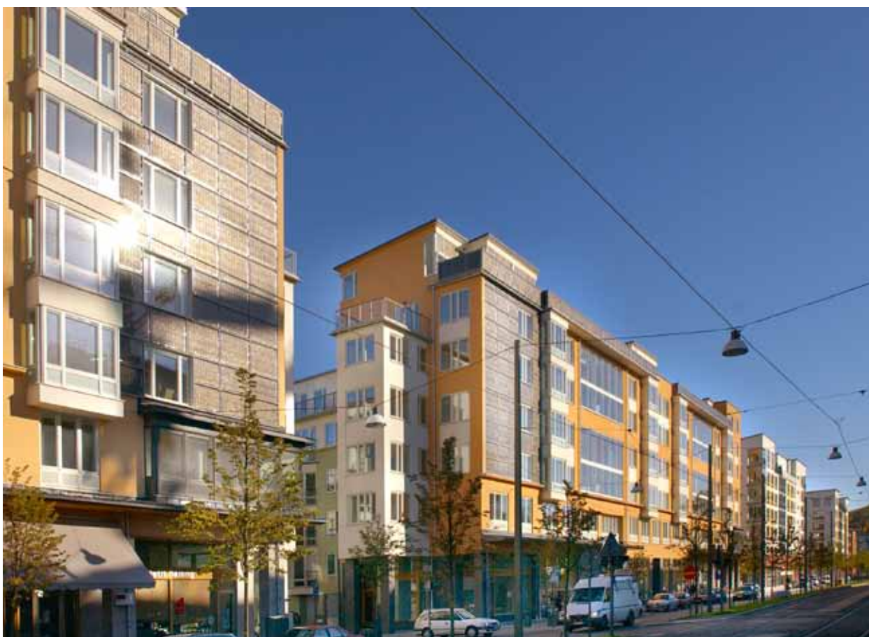
Solpanel som fasadelement, Hammarby Sjöstad.
