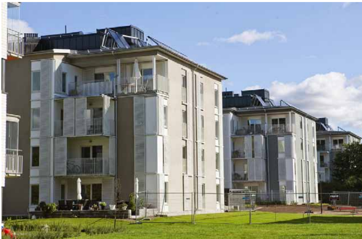
Lågenergihus i Beckomberga med solfångare på taket
