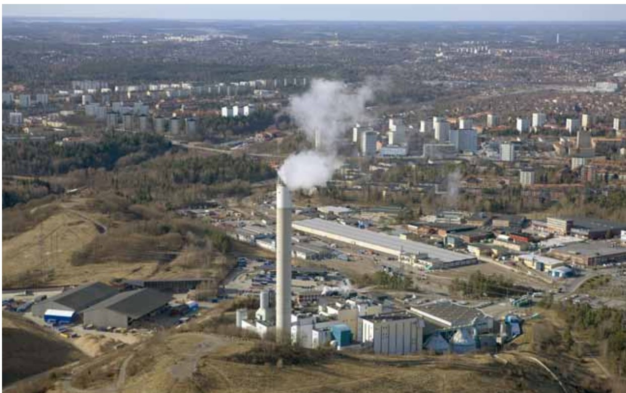
Högdalenverket är ett kraftvärmeverk som producerar både el och värme av främst hushålls och industriavfall.
