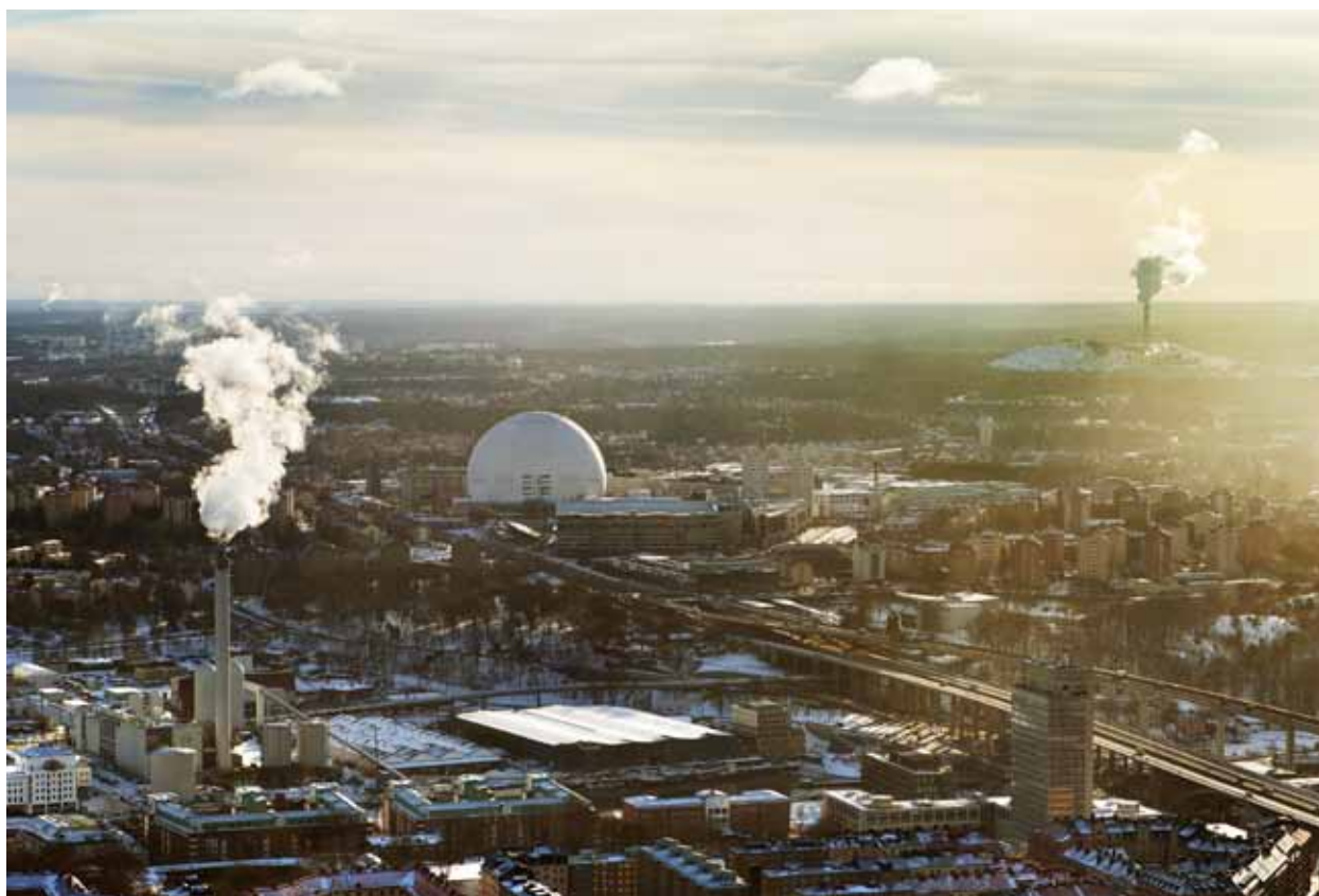
Hammarby värmeverk är en värmepumpsanläggning som hämtar värme ur renat avloppsvatten.
